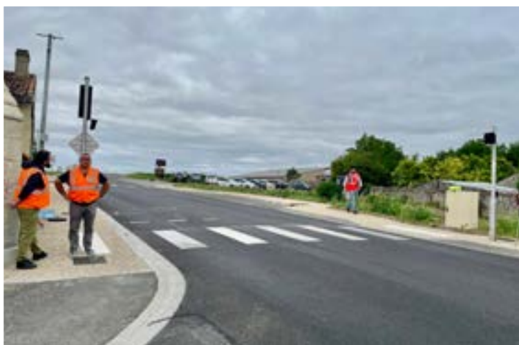
//Aménagement de la traverse de Vaon (RD347)
