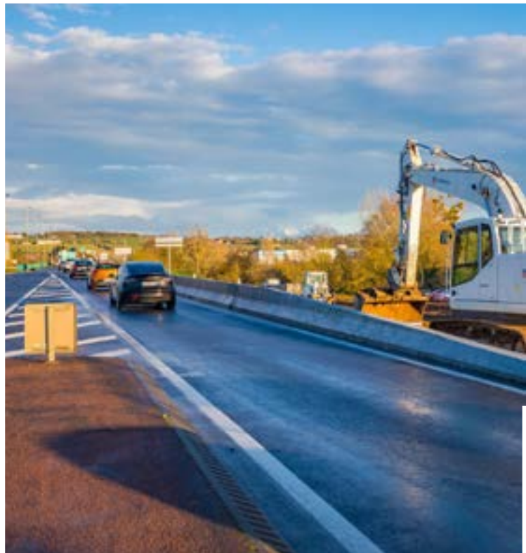
//Réhabilitation du pont Albert Camus à Châtellerauld (RD 103)
