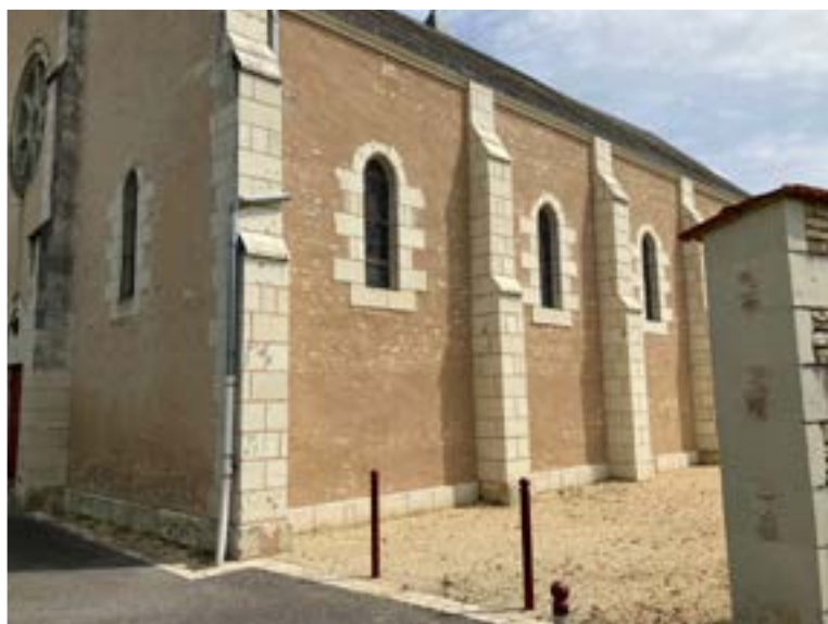
//Travaux des murs et toiture de l'église Saint-Clément (Saint-Jean-de-Sauves)
