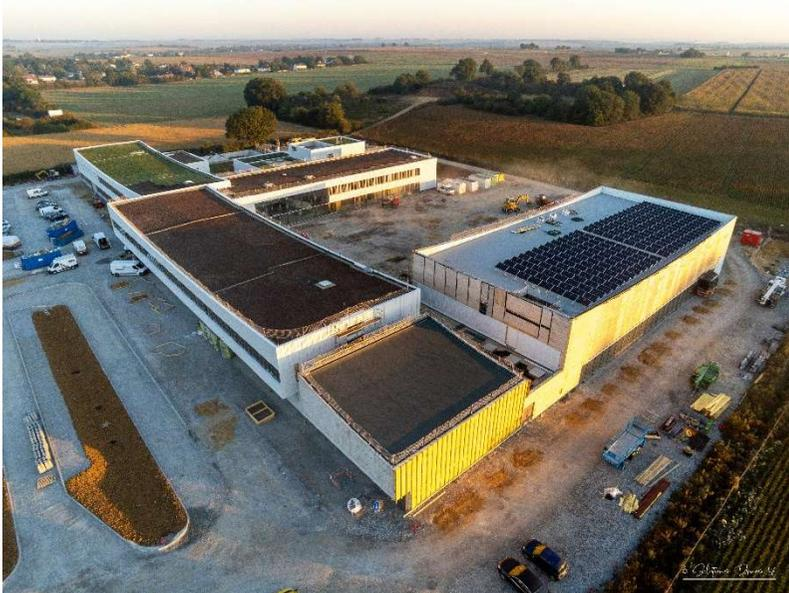
Chantier de l'ARENA (dalles photovoltaïques en toiture)
