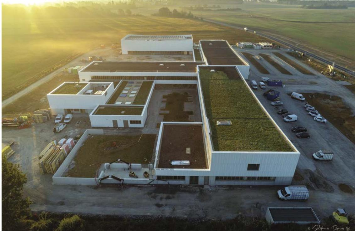
> Le 35<sup>e</sup> collège à Vouneuil-sous-Biard, en fin de construction, est un bâtiment sobre et efficace énergétiquement, d'où le choix d'une chaufferie bois et l'installation de panneaux photovoltaïques, l'emploi d'une structure en bois pour les étages et l'installation de toitures végétalisées pour le carbone.
