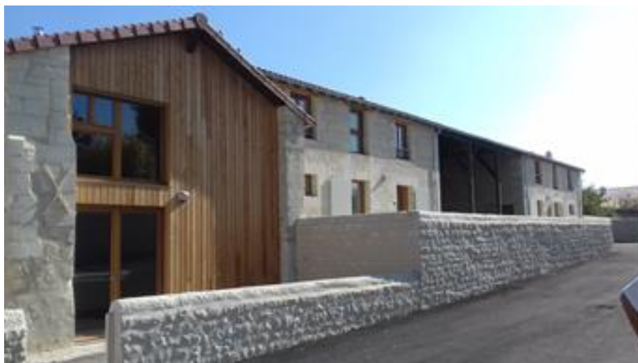
Restructuration du centre-bourg de Monts-sur-Guesnes financée dans le cadre de l'appel à projets
