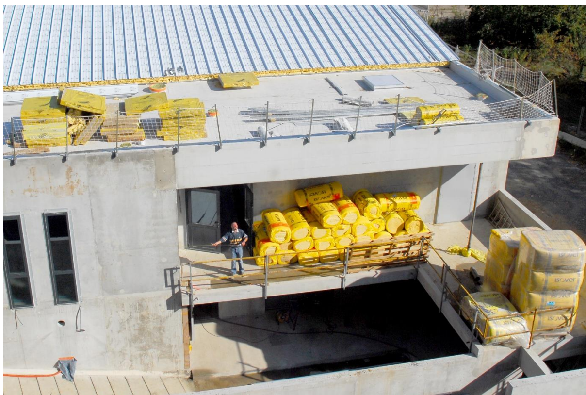
Travaux d'isolation de la demi-pension au collège de Chauvigny
