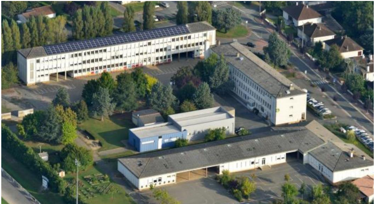
Panneaux photovoltaïques, collège Jean Monnet à Lusignan
