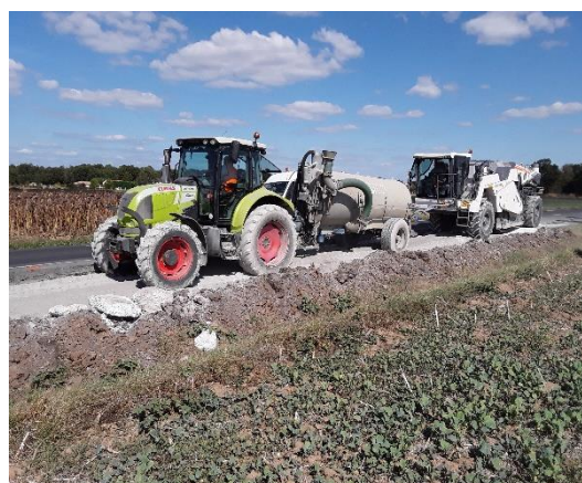
Chantier routier à fort taux de recyclage en 2019 sur la RD61
