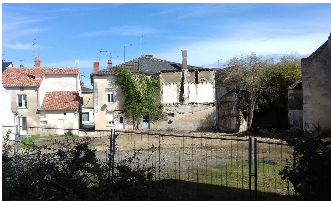
Chantier de densification du centre de Lenclôtre dans le cadre de l'appel à projets
